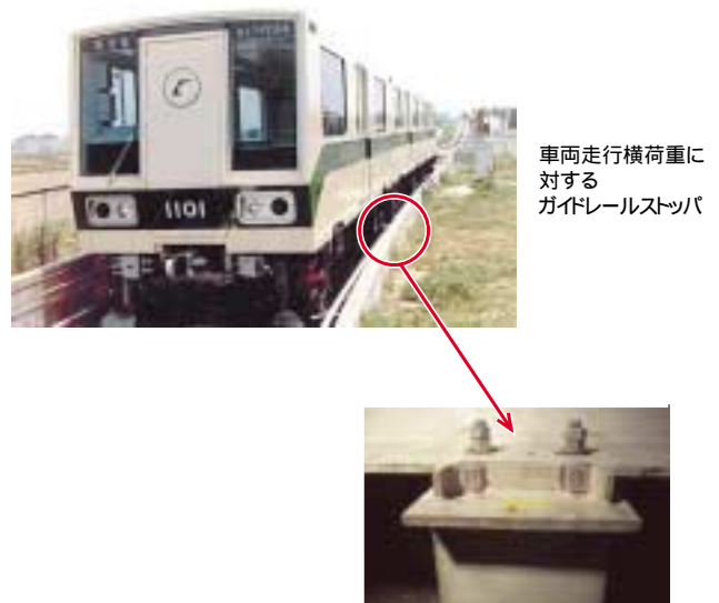
図5 鉄道軌道支持構造への貼付状況 Fig. 5 FDS application to rail support
