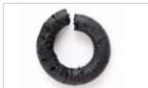
き裂、破断したOリング
