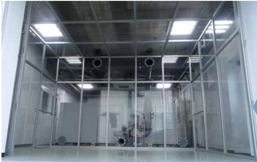
▲大型防じん試験室外観(試験槽寸法:W4.3m×D3.0m×H2.9m)
