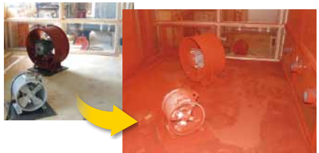
▲ 防じん試験状況
